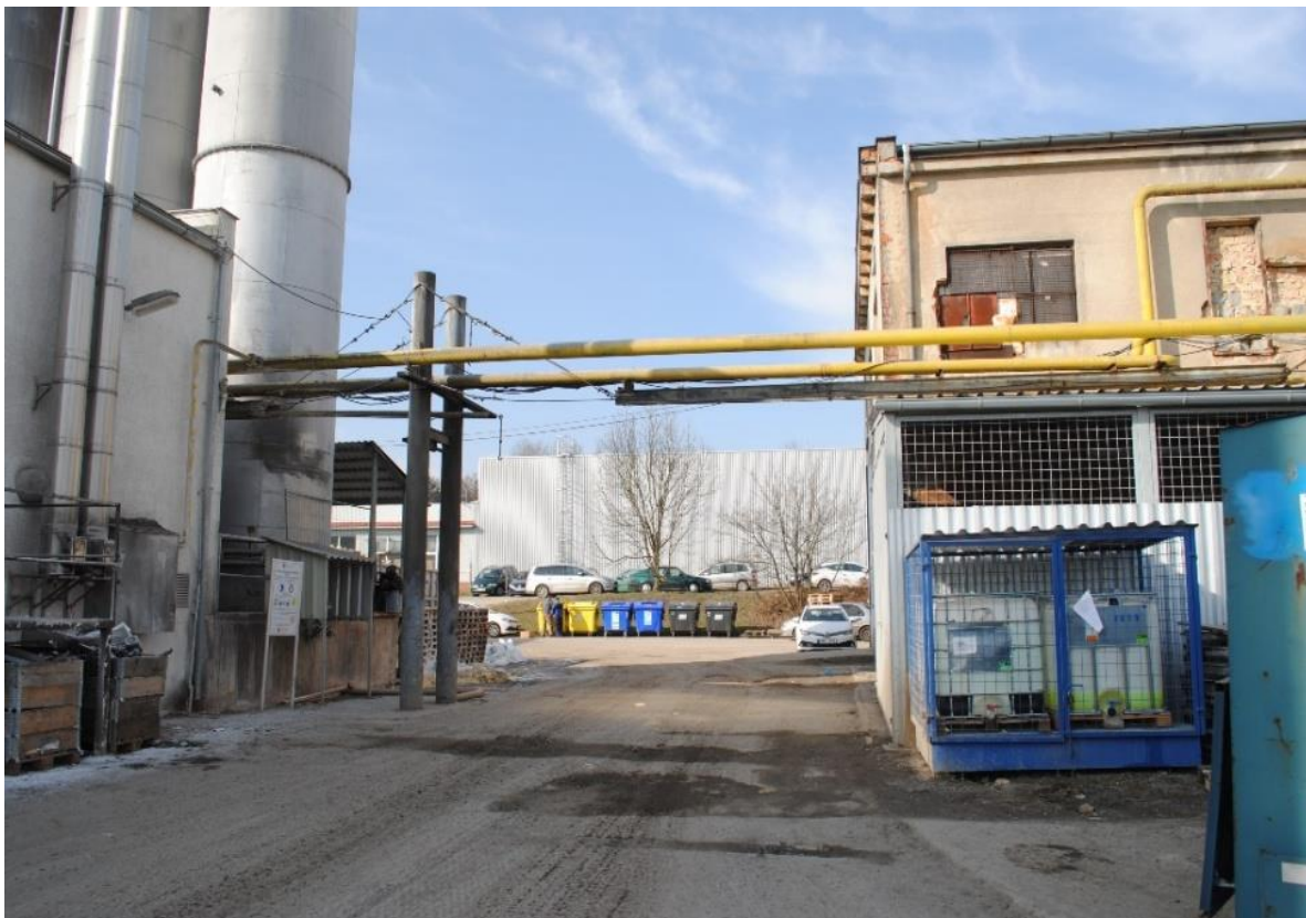
Obrázek 6 Zranitelné přemostění plynovodu; napravo mimo fotografii se nalézá regulační stanice plynu; vlevo se nachází moučná sila a budova výroby (zdroj: autor)
