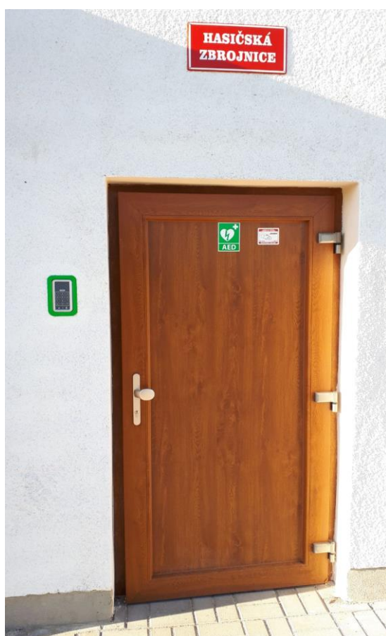
Obrázek 2: Vstupní dveře do zbrojnice s číselným otevíráním dveří [zdroj: vlastní]
