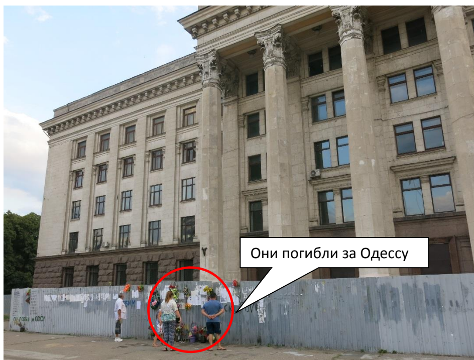
Obr. 2, Celkový pohled na improvizované pietní místo před Domem odborů (Smetana 2018)
