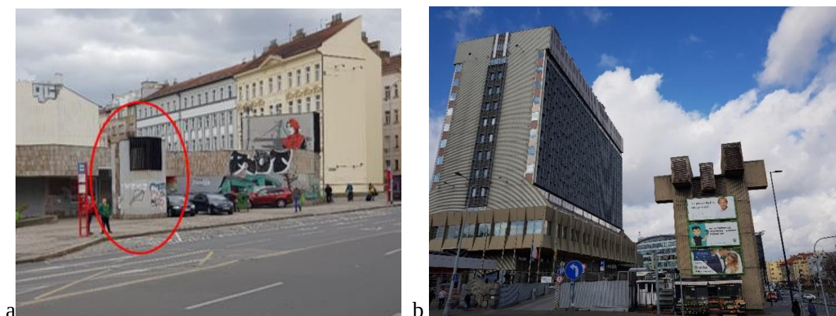
Obrázek 20 Příklady výdechů umístěných přímo do městské zástavby s pohybem osob nebo s průjezdem vozidel: a) výdech ze stanice Florenc B/C s přímým vyústěním na autobusovou zastávku v ulici Sokolovská, Praha 8; b) výdech ze stanice Pražského povstání C s přímým vyústěním před budovu Ministerstva vnitra ČR Centrotex a na frekventovanou křižovatku ulic Na Pankráci x Děkanská vinice I, Praha 5 (zdroj: autor).
