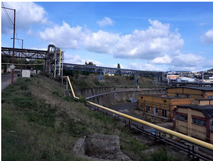
Obrázek 63 Stěna lemující objekty Chlorové chemie od západu a severu [zdroj vlastní]
