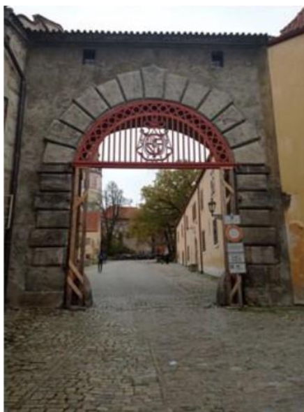
Obrázek 7. Vstup na první nádvoří (zdroj: vlastní)
